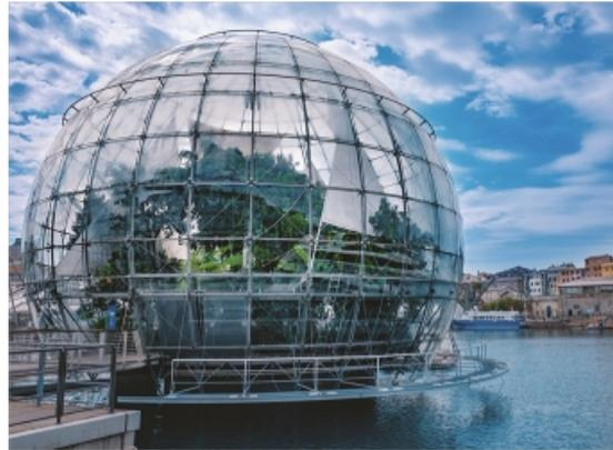
**GENOVA (GE)** - La Biosfera è una struttura di vetro e acciaio con un diametro di 20 metri che pesa complessivamente 60 tonnellate. Ospita un insieme complesso di organismi tropicali...
